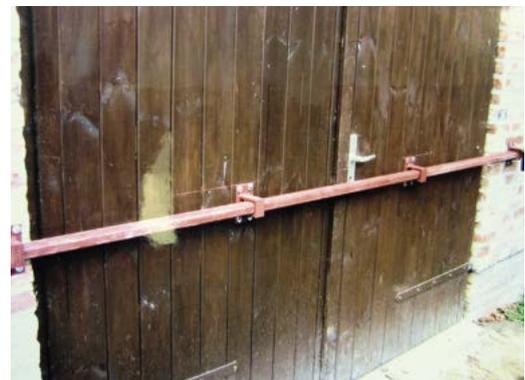
**Tipp:** Eine günstige Alternative zur Sicherung einer Keller- oder Hintertür ist das Anbringen einer Vorlegestange (Stahl- oder Hartholz).
